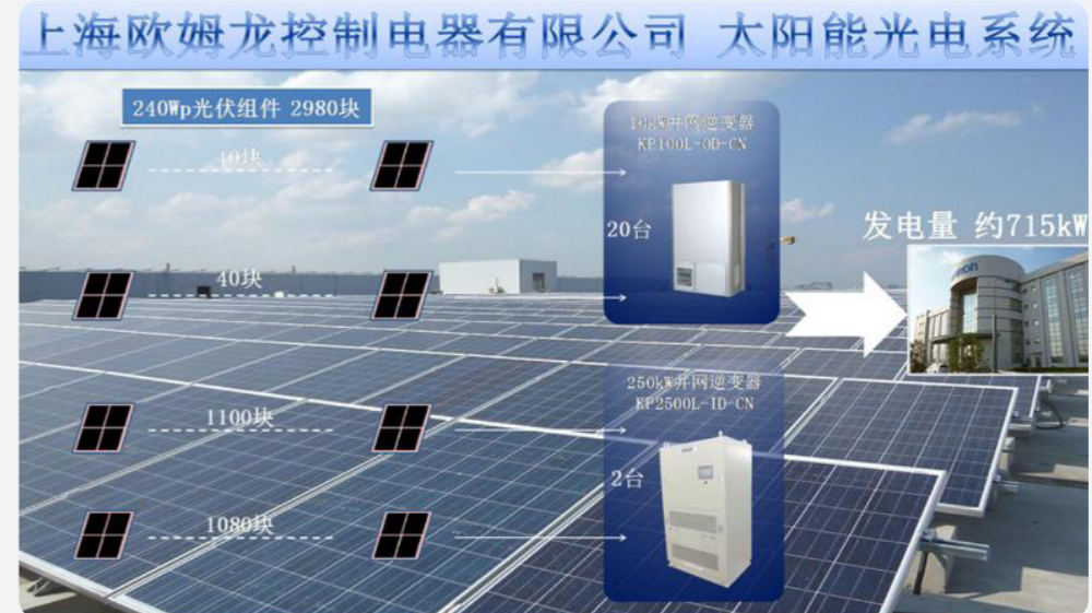
上海欧姆龙控制电器有限公司太阳能发电组件
